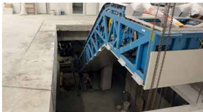
Монтаж несущей рамы поэтажного эскалатора к железобетонным плитам перекрытия торгового центра (ТЦ «Галерея», г. Краснодар, 2011 г.)
